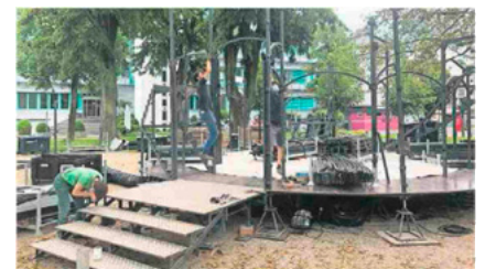
Am Sonntag begann der drei Tage dauernde Aufbau des Silos.
